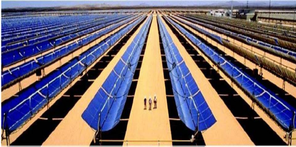
Fig 6.2.12 O porțiune de câmp cu colectoare solare cilindro-parabolice a centralei termice Kramer Junction, California
